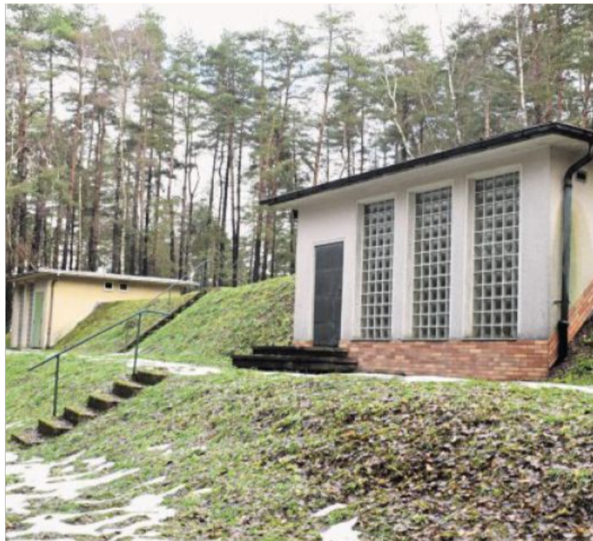
Die Sanierung des Hochbehälters II in Woppenhof ist eine der nächsten Aufgaben des Zweckverbandes Glaubendorfer Gruppe. Der Hochbehälter I (im Hintergrund) wird stillgelegt. Bild: bnr
