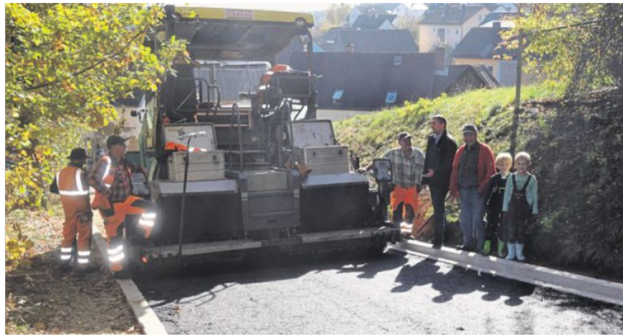
Der Fertiger zieht die neue Asphaltdecke auf. Die beiden Enkel von Altbürgermeister Hans Götz schauen da begeistert zu, während Bürgermeister Markus Ziegler Details mit dem Bauleiter (von rechts) bespricht. Bild: fz
